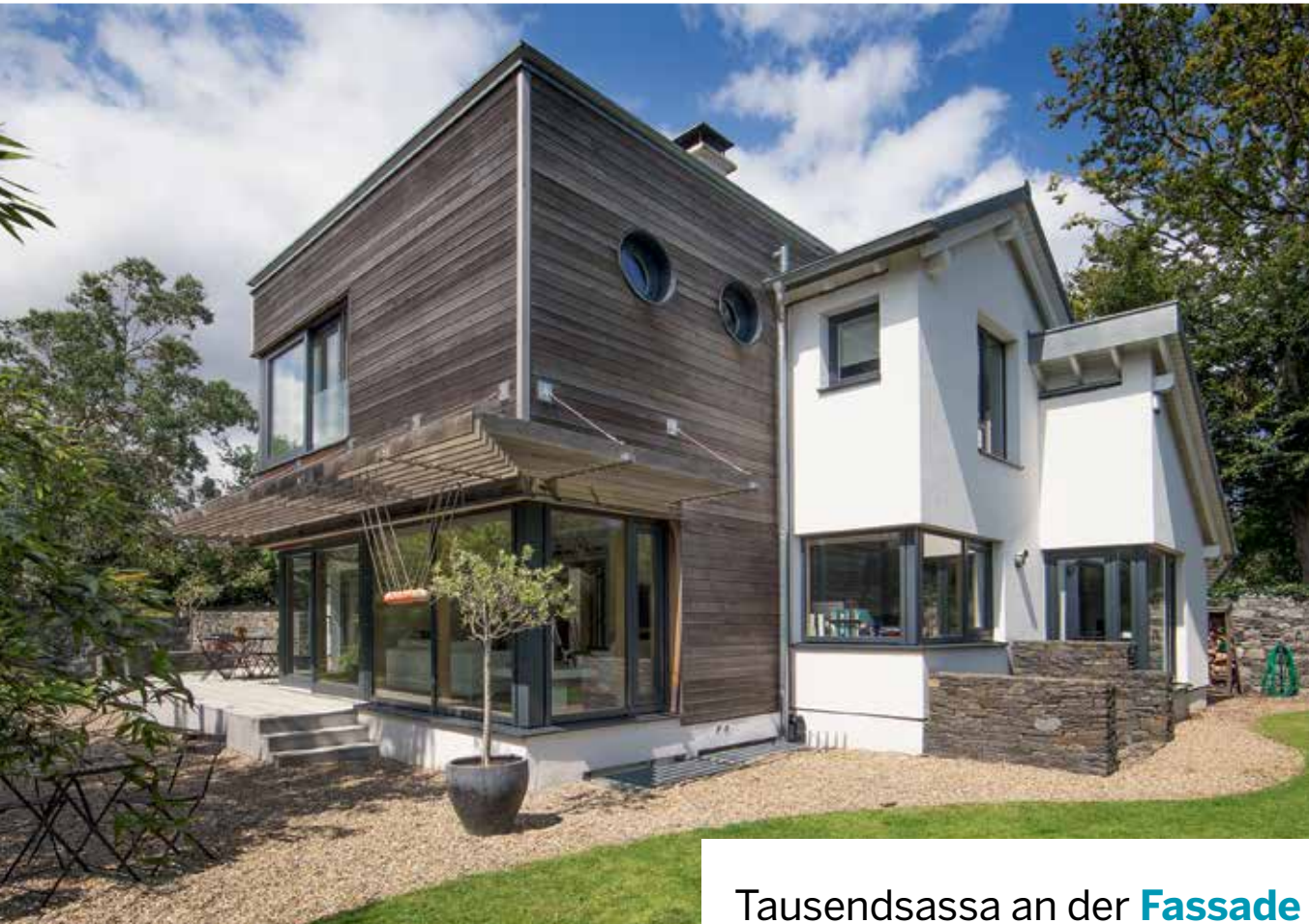
Munterer Kontrast der Materialien und Formen: traditionelles Seildach trifft auf Flachdach, säge- raue Red-Cedar-Schalung auf weißem Edelputz.
